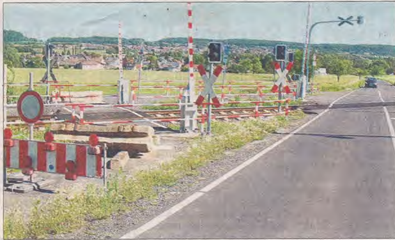
Vorentscheidung gefallen: Da die DB den Anschluss am Bahnübergang bei Rödgen schon gebaut hat, ist die Straßenseite, auf der der Rad-/Gehweg angelegt wird, praktisch schon vorgegeben.
